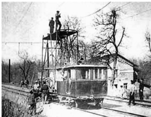
Рис. 105. Работы по электрификации Минераловодской ветви железной дороги. Фото 1930-х гг.
